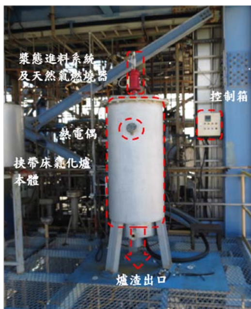
圖十一、10kg/hr 漿態燃料扶帶床氣化爐實體圖。
