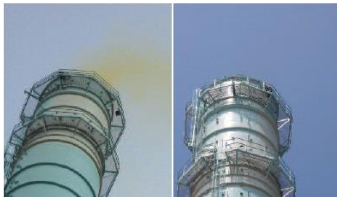
圖 5 一般複循環機組起爐期間因 NO 2 形成黃棕色排煙
